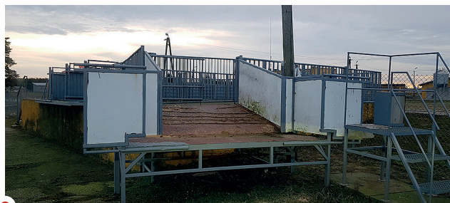
Fot. 13. Rampa, Polska 2018
