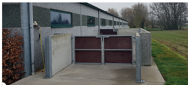
Fot. 14. Rampa, Belgia 2020
